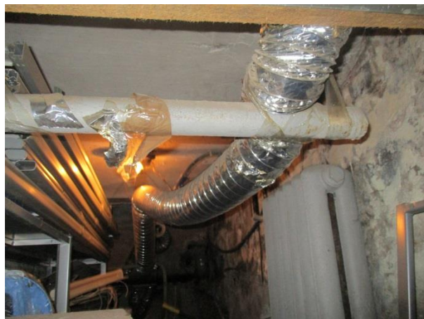
Ф.2.2 Общий вид помещений подвала здания
