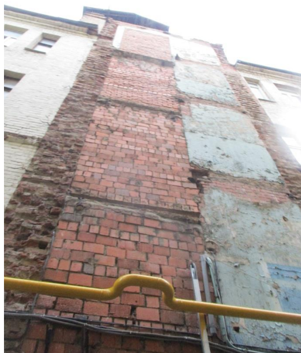
Ф.1.4 Общий вид демонтированного перехода между зданиями в осях 3-5/А
