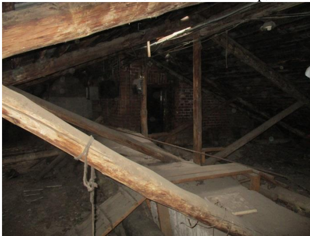
Ф.3.3 Общий вид помещений чердака
