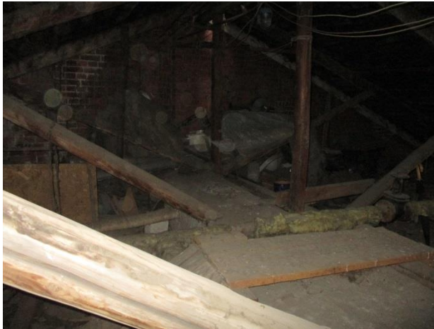
Ф.3.1 Общий вид помещений чердака
