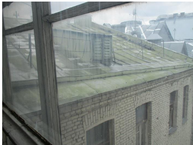
Ф.1.6 Общий вид кровли здания в осях 8-10/A-B
