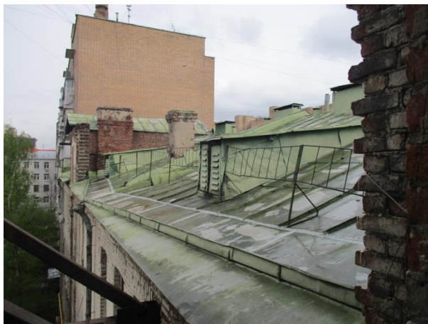
Ф.1.5 Общий вид кровли здания в осях 5-7/A-B
