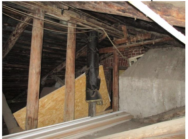
Ф.3.4 Общий вид помещений чердака
