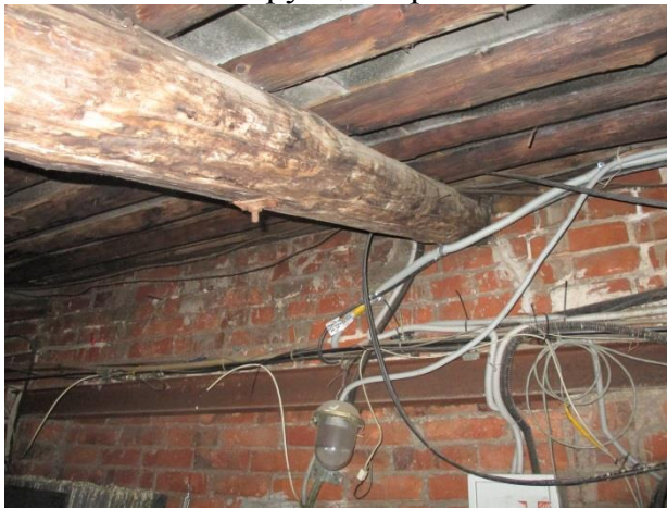
Ф.3.9 Следы протечек и увлажнений
