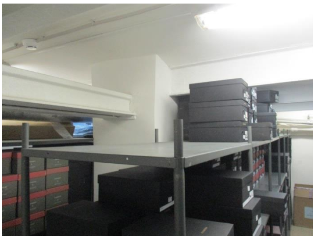
Ф.2.1 Общий вид помещений подвала здания
